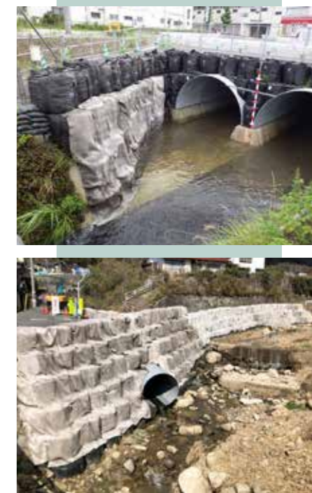
大型土のう被覆工
