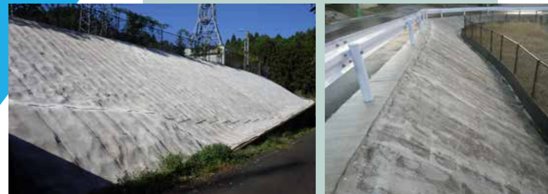
法面保護工・防草工・鳥獣掘起し対策工
