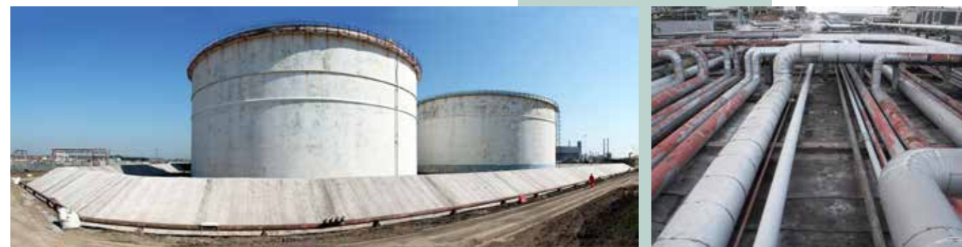
工場施設内 被覆工
