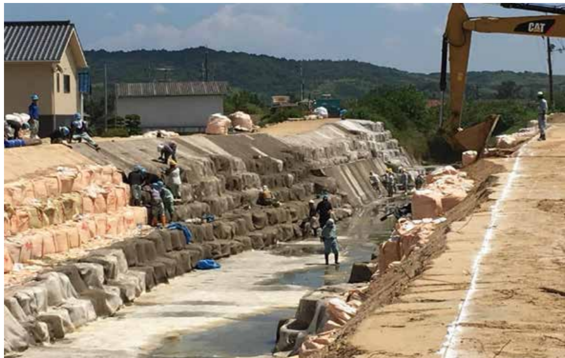
西日本豪雨 仮 未政川堤防決壊応急復旧 (岡山県真備町)
