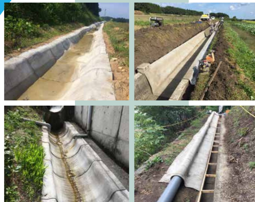
水路工・水路補修工
