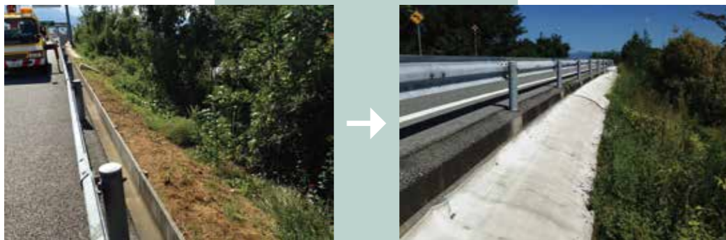
法面保護工・防草防竹工
