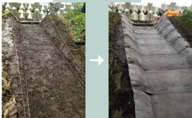
吐水口侵食防止工
