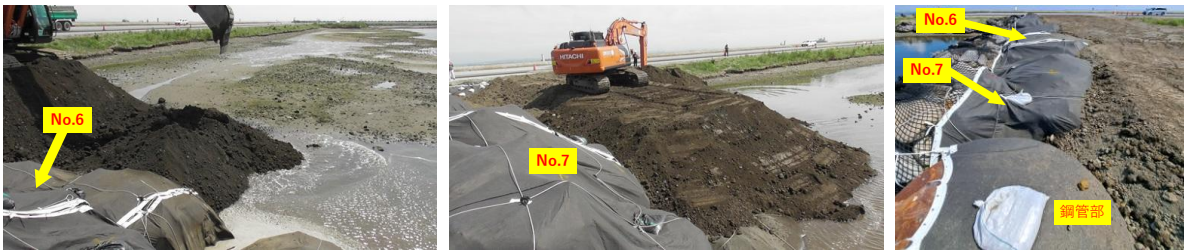
写真-12 対策有りシートの埋立て状況
