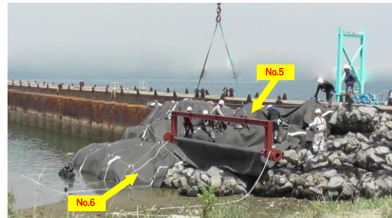
写真-6 対策無しシートの敷設状況 (No.5)
