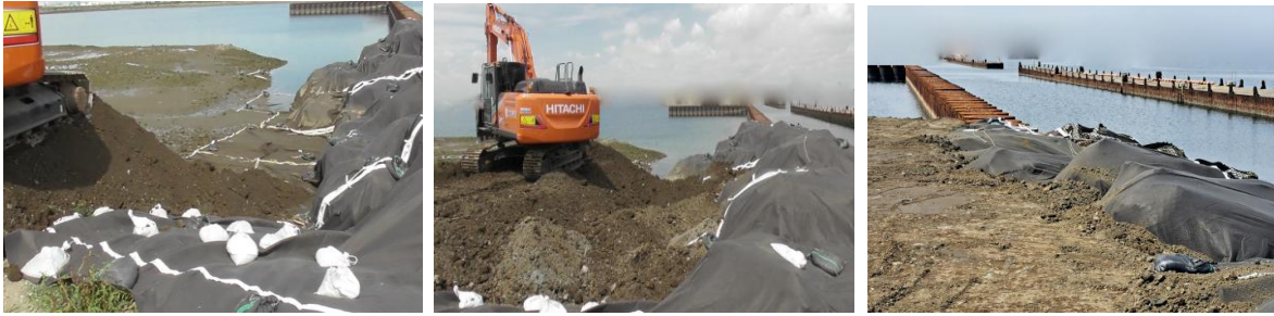
写真-11 対策無しシートの埋立て状況
