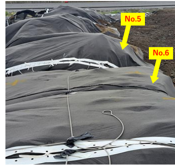
写真-16 対策有りシートの張り具合、シート No.6
