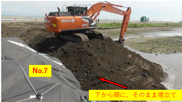
写真-15 対策有りシート No.7 付近 埋立て状況
