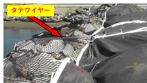
写真-10 タテワイヤー緊張確認 (上端固定部)
