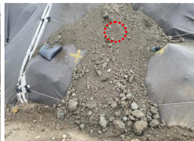
写真-21 埋立状況、シート No.6
