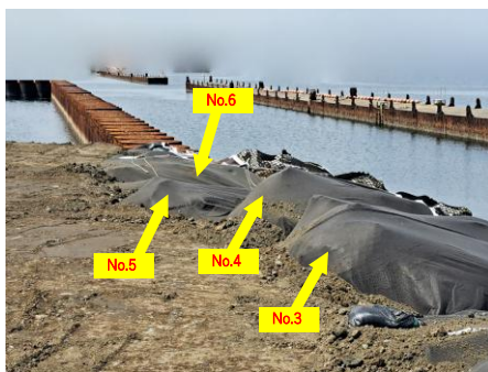
写真-17 対策無しシートの張り具合 シート No.5、4、3
