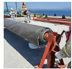
写真-4 防砂シート展開と巻取り状況
