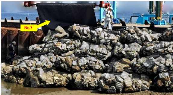
写真-5 対策有りシートの敷設状況
