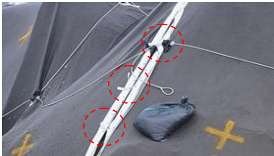
写真-7 防砂シート同士の結束状況 (赤丸部)
