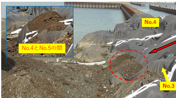
写真-13 対策無しシート 引き込み対策状況
